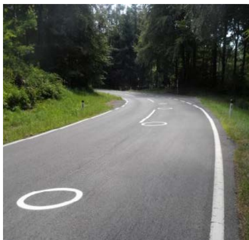
Image 5: special road marking on PTW driving lines © KFV (Kuratorium für Verkehrssicherheit), Austria
